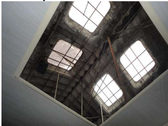
Cielorraso y cubierta local 1
