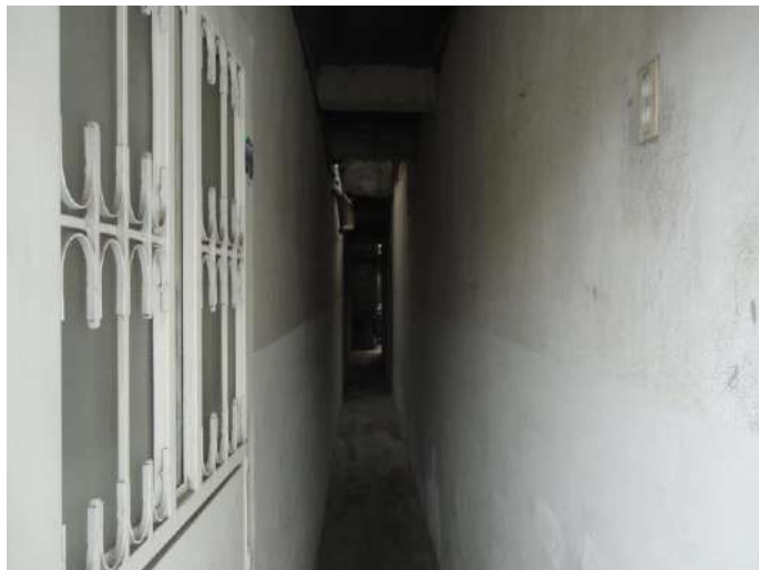
Corredor de acceso
