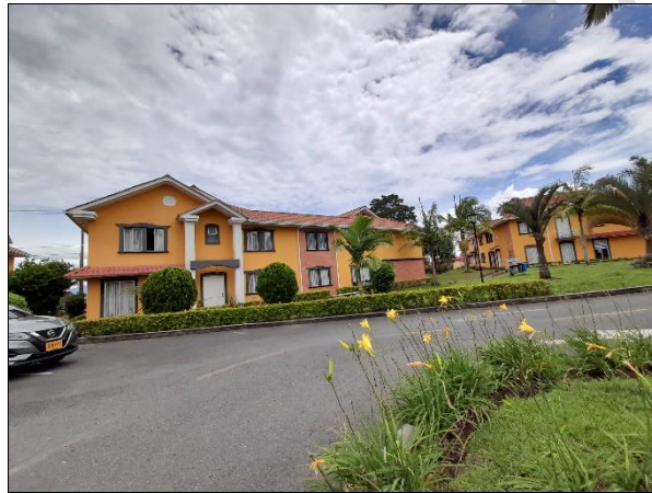
VISTA GENERAL INTERIOR DEL CONJUNTO
