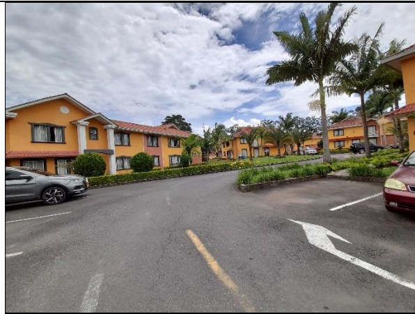
VISTA GENERAL INTERIOR DEL CONJUNTO
