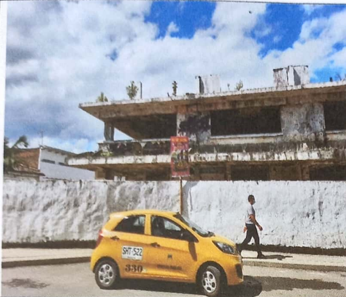
Detalles del estado actual
