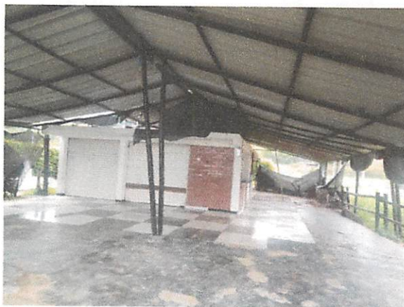
CUBIERTA EN GUADUA Y ZINC
