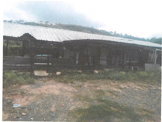
PANARAMICA DEL INMUEBLE
