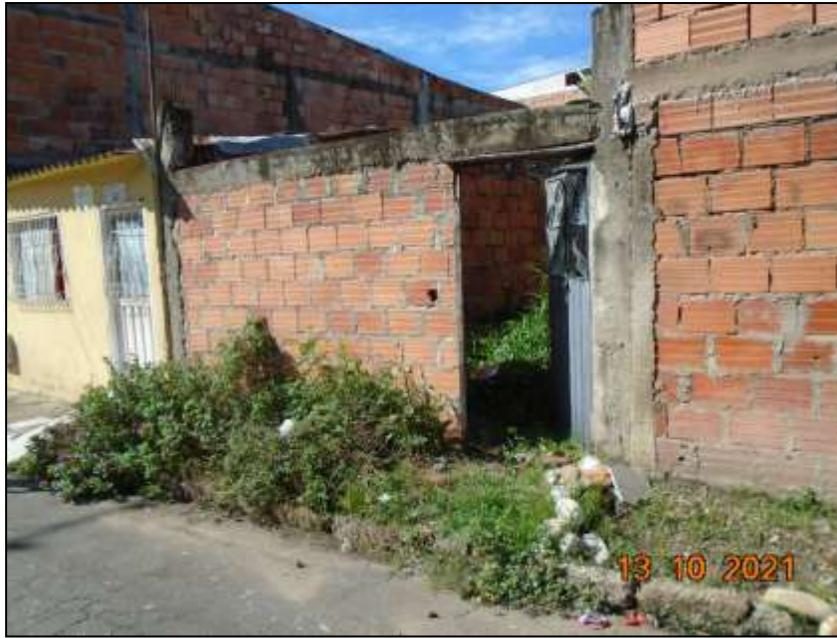
MURO CERRAMIENTO EN BLOQUE CON UNA PUERTA METALICA CON CADENA Y CANDADO, EN LA PARTE SUPERIOR UNA VIGA DE AMARRE EN CONCRETO. NO PRESENTA ANDEN Y HAY VESTIGIOS DE UN CONTADOR DE ACUEDUCTO. REGULAR ESTADO.
