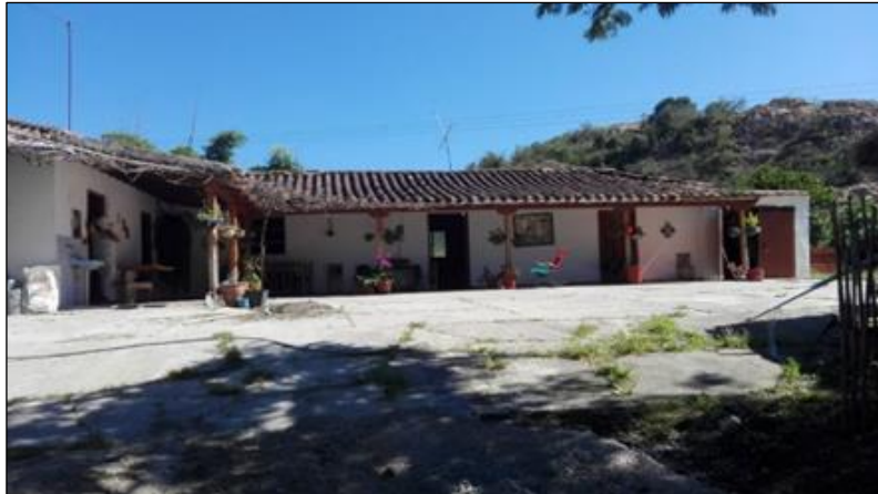
Casa principal del predio.
