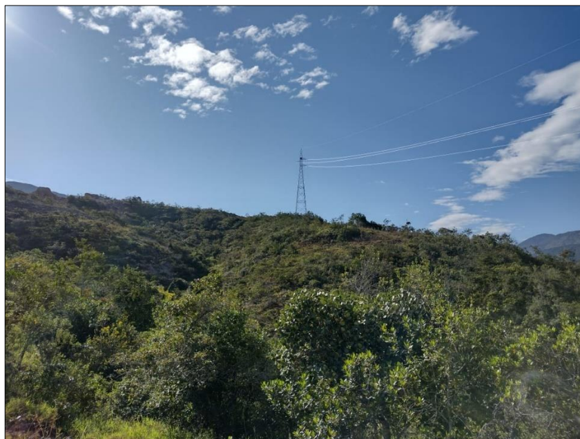
Acercamiento de la torre de energía y la línea de servidumbre eléctrica
