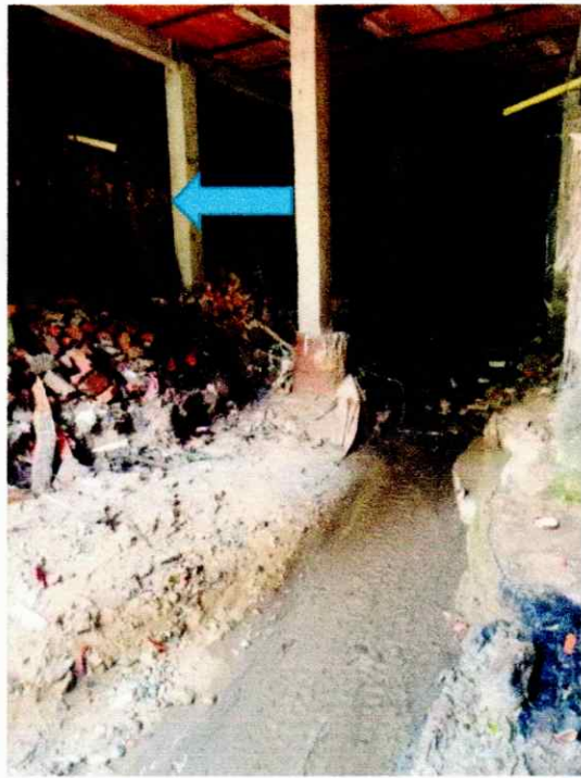
Las flechas azules indican el punto del muro en peligro de colapsar
