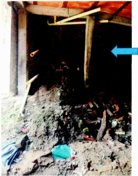
Las flechas azules indican el punto del muro en peligro de colapsar
