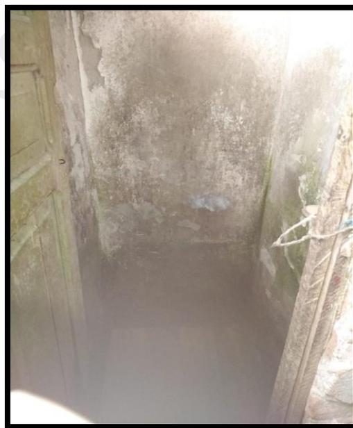
**MEJORA N° 3.** Área antigua cochera, hoy bodega de reciclaje, la construcción se encuentra en **RUINAS**, no posee paredes superiores, al igual que puertas o ventanas, sin sistema eléctrico e hidráulico, pisos deteriorados en cemento crudo.
