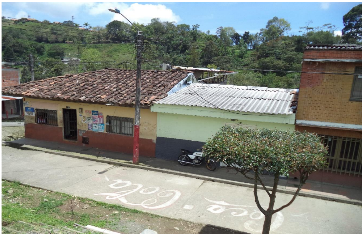
Casa desde su exterior
