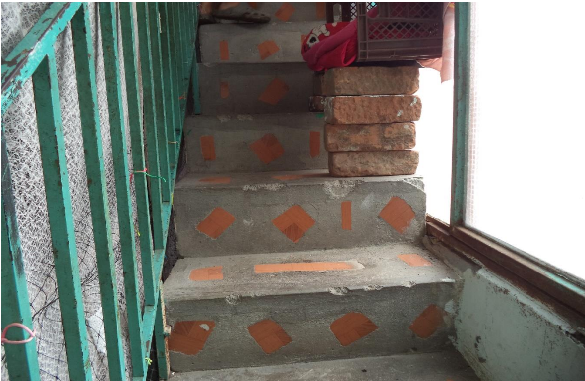
escaleras de acceso terraza
