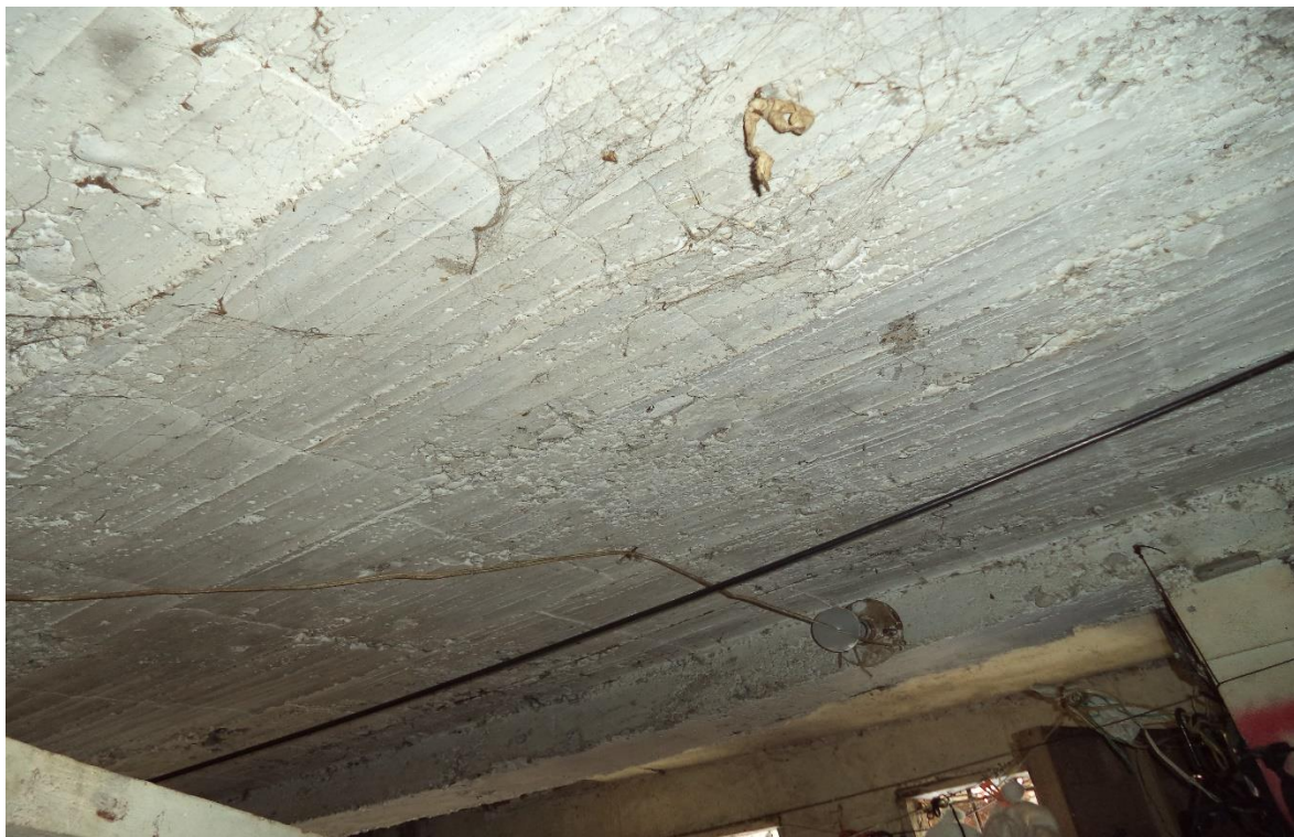
Placa de concreto
