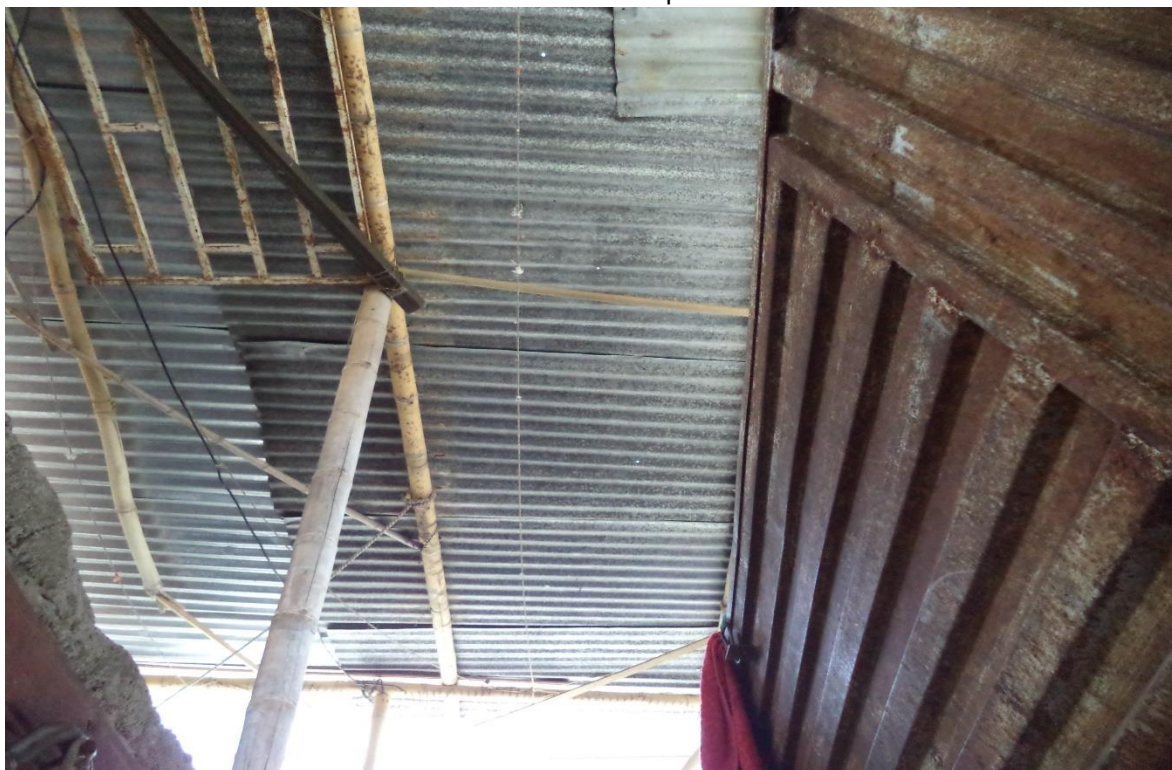
Cubierta del área de ropas en zinc
