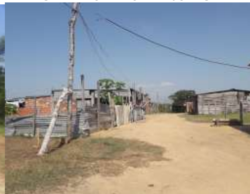
MEJORAS EN MADERA- LADRILLO
