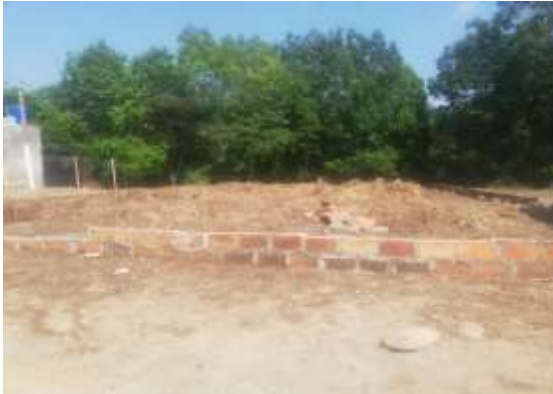
MEJORA EN CONSTRUCCION
