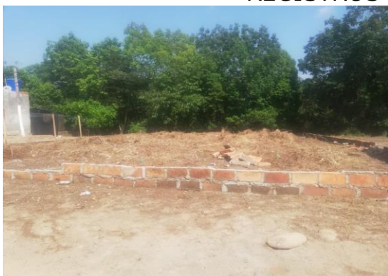
MEJORA EN CONSTRUCCION
