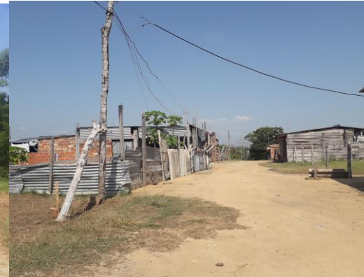
MEJORAS EN MADERA- LADRILLO
