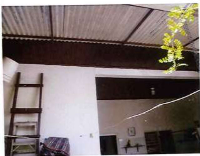
Mejora techo patio
