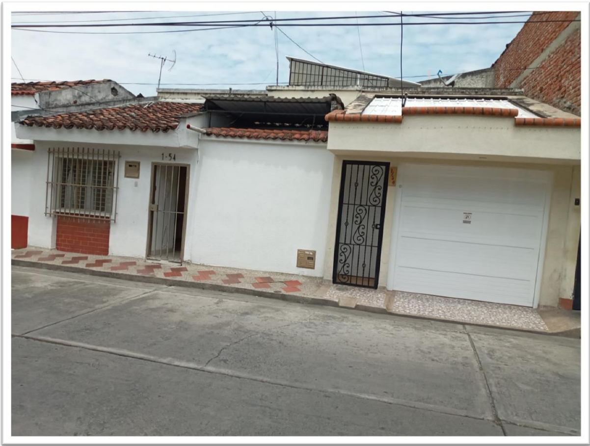
Foto 2. Fachada del predio con nomenclatura, Calle 6 N° 1-54.
