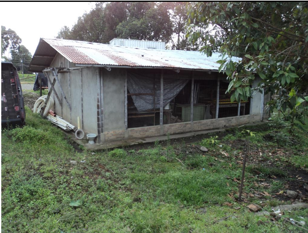
N° 13.- Bodega utilizado por la Empresa
