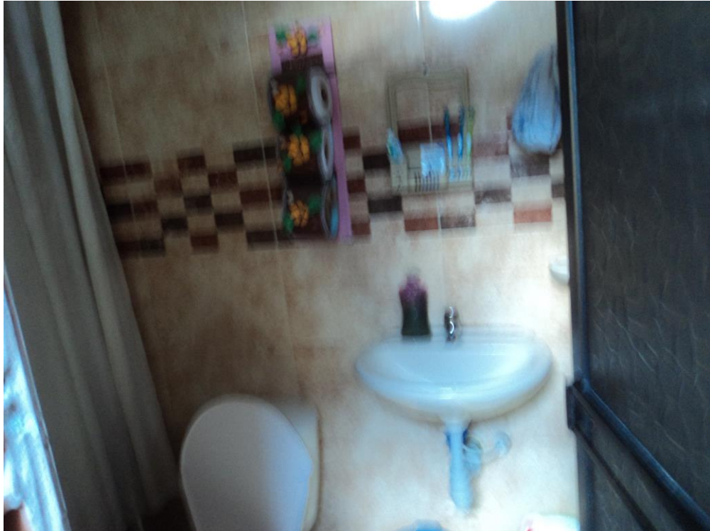
N° 8.- Parte del baño integral, observamos el lavamanos, inodoro y un muro enchapado en cerámica, puerta en acrílico en la parte derecha de la fotografía.
