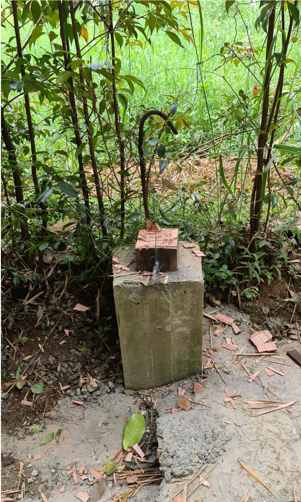
IMAGEN DE LOS DAÑOS CAUSADOS POR EL DEMANDANTE AL PORTON DE LA PARCELA VILLA CRISTAL
