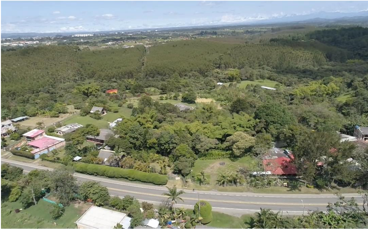
PREDIO DEL DEMANDANTE – RESTAURANTE LOS GUADUALES FRENTE A LA VÍA PANAMERICANA
