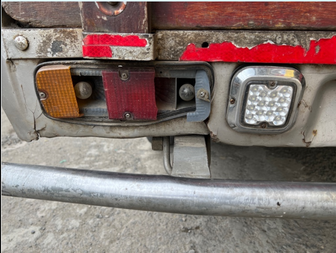
Imagen Nº 9: se aprecia parte posterior donde se evidencia conjunto del stop, en mal estado de conservación mal estado de funcionamiento.
