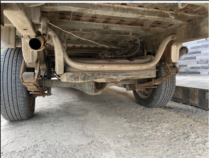
Imagen Nº 11: se evidencia parte inferior, donde se evidencia algunos componentes, de la seguridad activa, de igual forma se aprecia mucha oxidación en la mayoría de componentes inferiores
