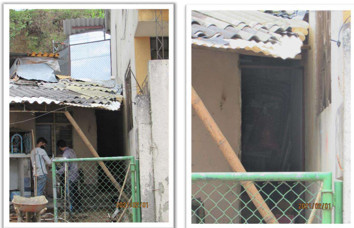
FOTO 8.- PASILLO CUBIERTO PREDIO SIRVIENTE
