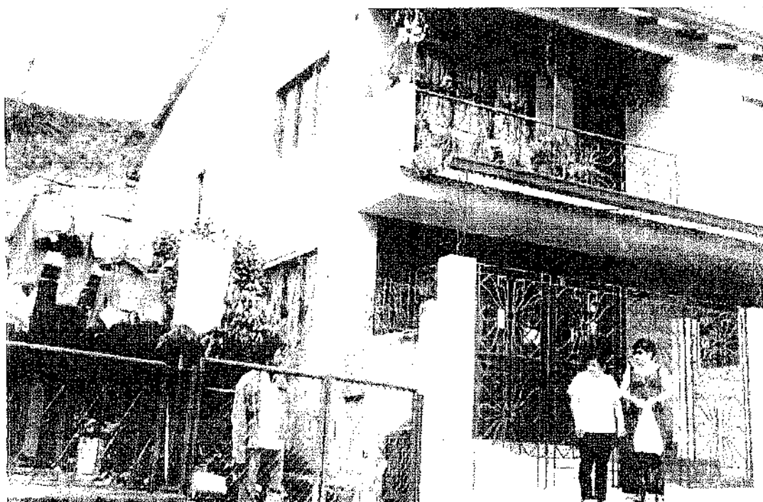
- FRENTE Y LADO NORTE DE LA CASA -
