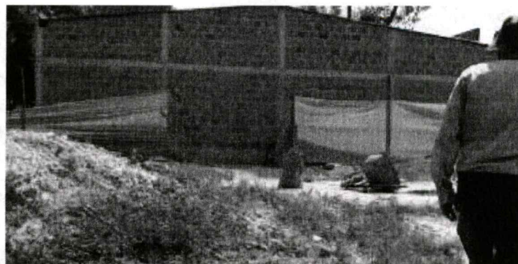
Ilustración 6 CONSTRUCCION DE ANDRES MANCIPE
