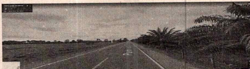
FOTOGRAFIA No.2: Sentido San Alberto – La Lizama (fuente streetview 2018), donde se observan las características generales del tramo de vía en aproximación al Km 70+300, demarcación y morfología general.
