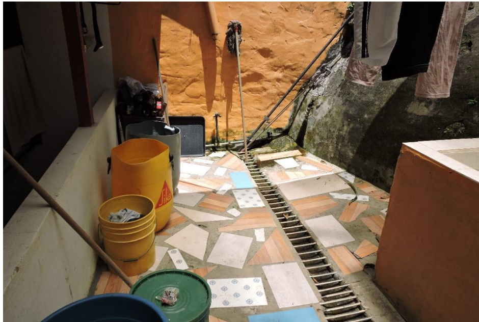
Foto 12: Vista del patio al interior de la construcción, se observa que la construcción se encuentra levantada sobre una roca la cual da estabilidad a la construcción.
