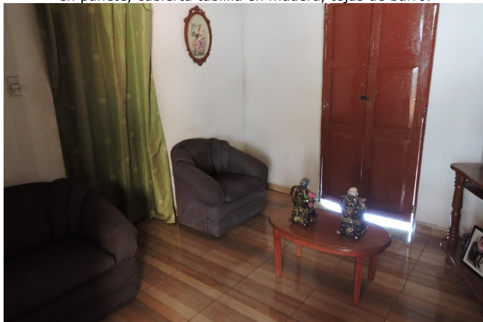
Foto 4: Vista sala de estar, construcción apartamento 201, piso en baldosa cerámica, paredes en pañete, cubierta tablilla en madera, tejas de barro.
