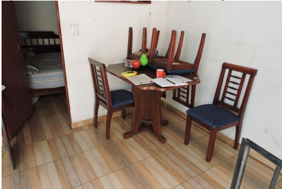
Foto 5: Vista sala comedor, construcción segundo nivel, piso en cerámica, paredes en pañete, puertas en madera, cubierta tablilla en madera, tejas de barro.
