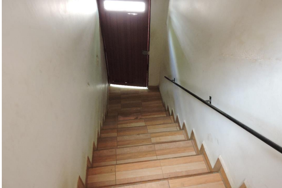
Foto 3: Vista al interior, escalas de acceso desde el primer piso, enchape en baldosa en cerámica glaseada, pasamanos de apoyo, paredes en pañete, pintadas.
