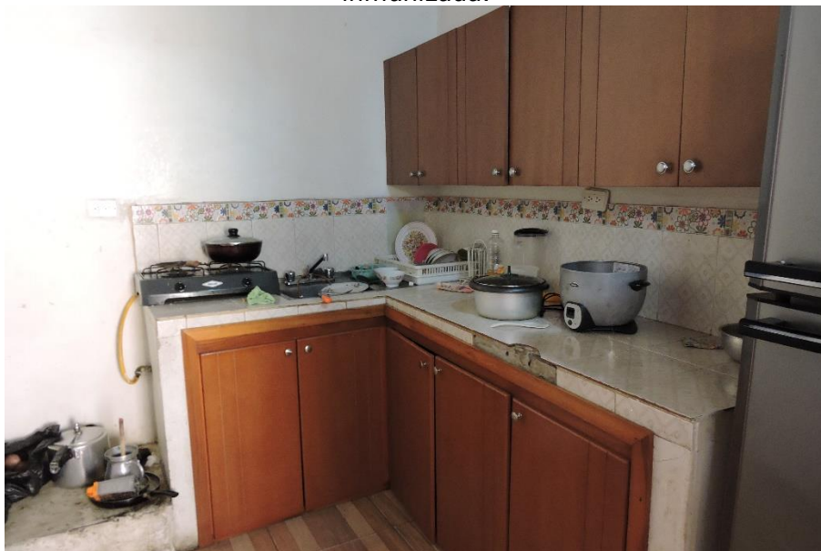
Foto 6: Vista a la cocina, enchape baldosa cerámica, gabinetes y alacena en madera fina inmunizada.
