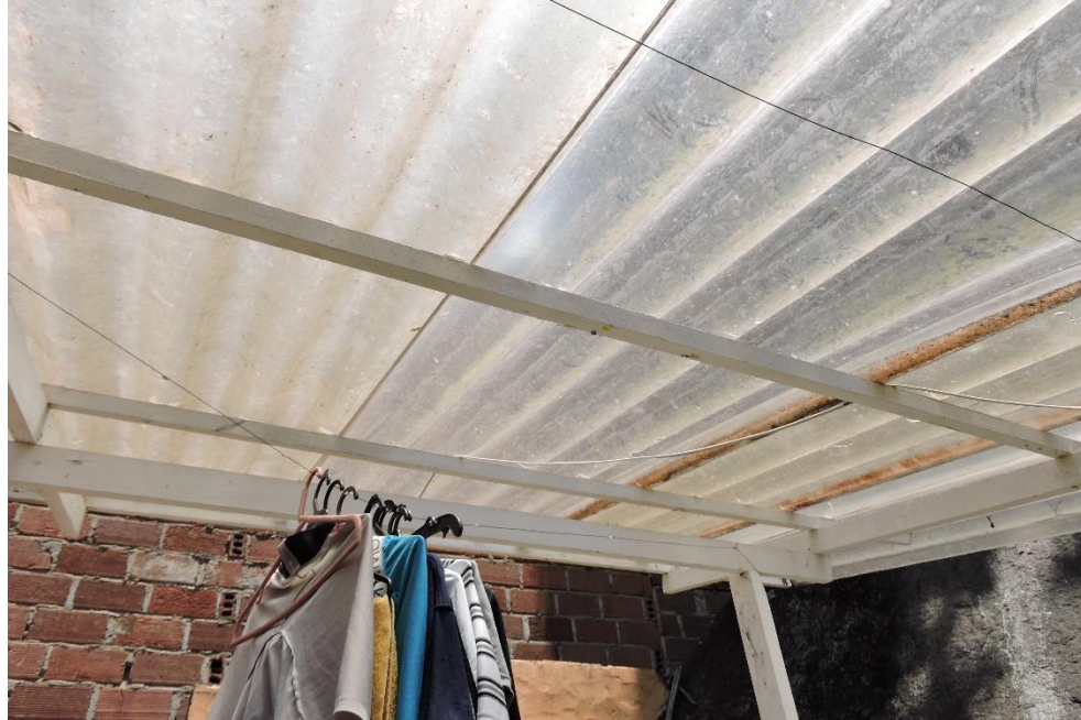
Foto 13: Vista de cubierta del patio en tejas plásticas translúcidas, marco en lámina.
