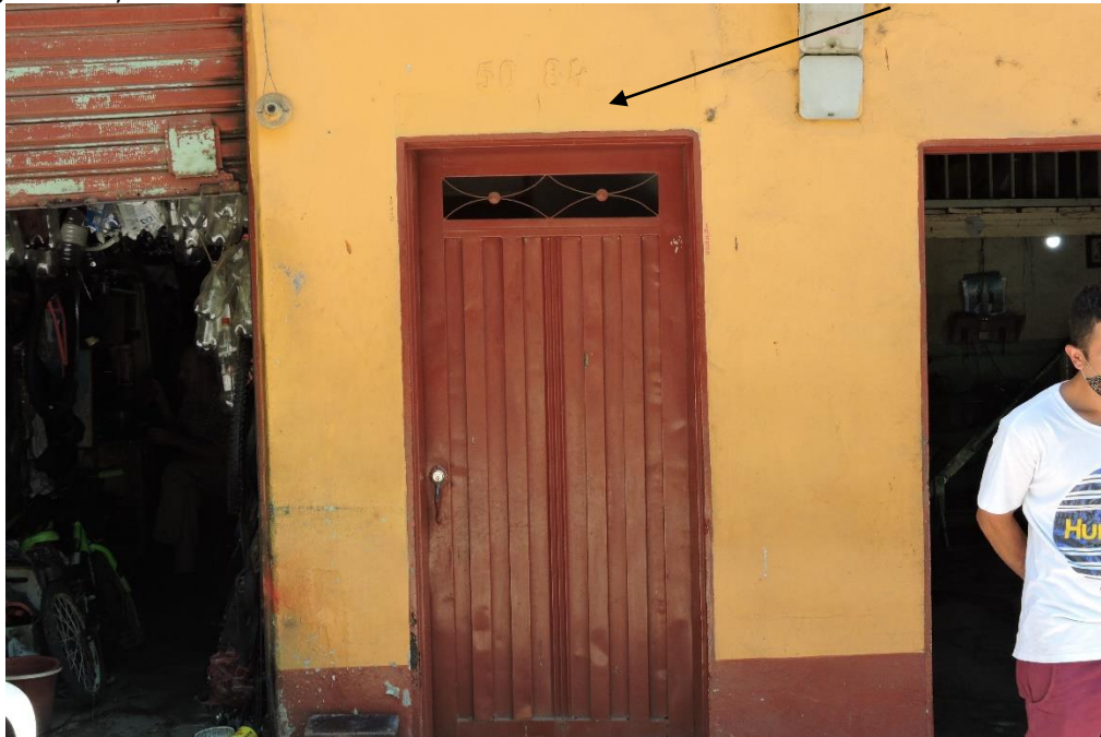
Foto 2: Vista al acceso para el segundo piso, Puerta de acceso desde el primer piso por la Diagonal 53, lado oriental del inmueble con FMI 004-39387. Nomenclatura N. 50-84
