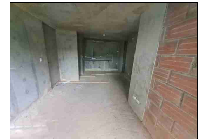
Foto 5. 5.SALA COMEDOR Y COCINA.jpg
