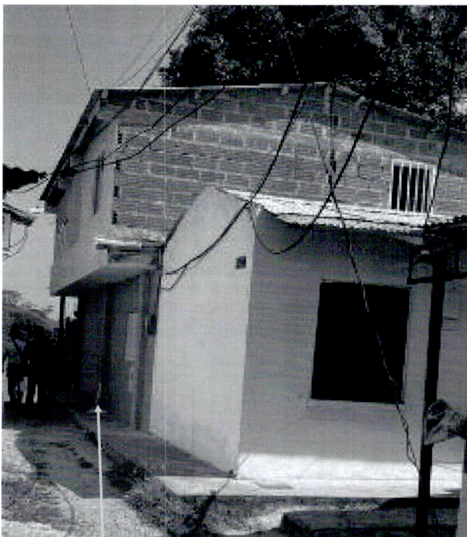
VISTA EXTERIOR EL INMUEBLE
