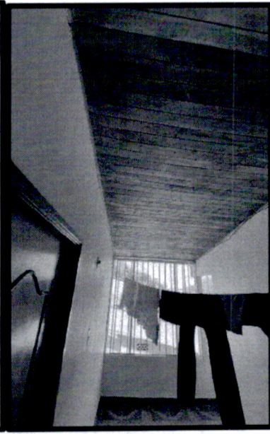
Techo en machimbre
