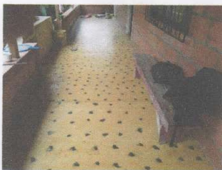
Piso en cemento con mineral y adobe a la vista
