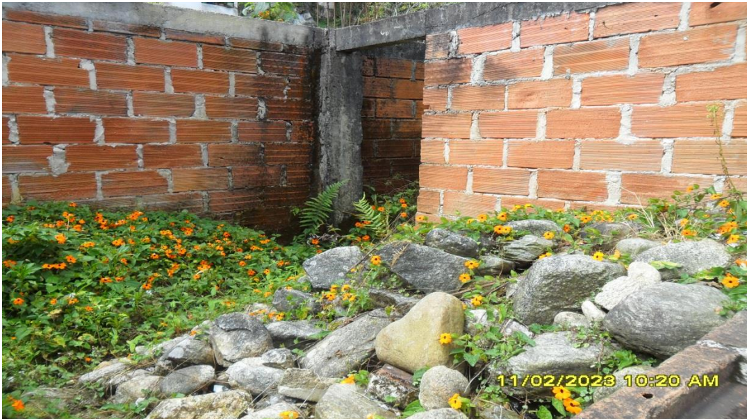
INTERIOR DE LA CONSTRUCCIÓN
