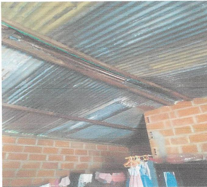
La habitación se encuentra cubierta en teja de zinc que lo sostiene una estructura en madera en buenas condiciones.
