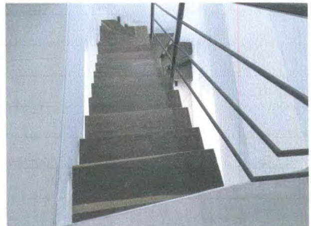
Escalera vista arriba hacia abajo.
