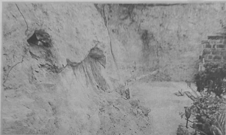
Figura 1. Delimitación zona de fracturamiento y zona de deposición de material erosionado en el predio con ficha catastral 01-00-0452-0023-000.
