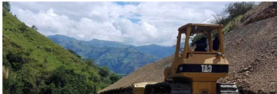
Colocación del relave seco en el depósito.
