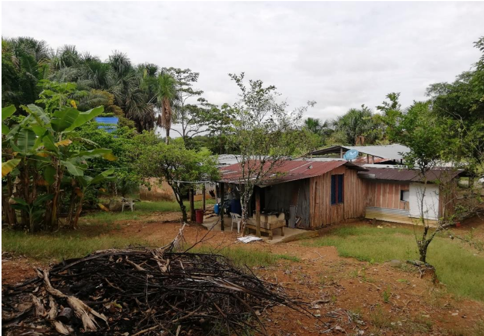
Detalle casa existente fachada posterior
