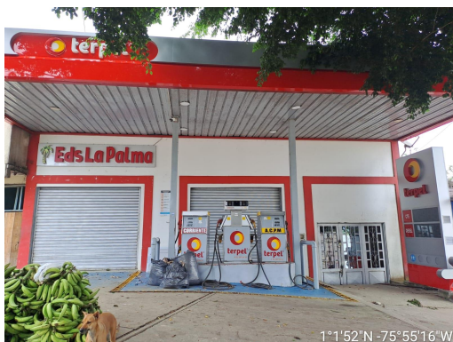
Fachada Estación de Servicio
