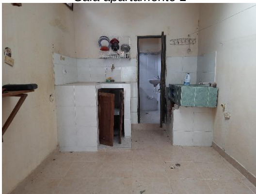
Detalle zona de ropas, cocineta apto. 1
