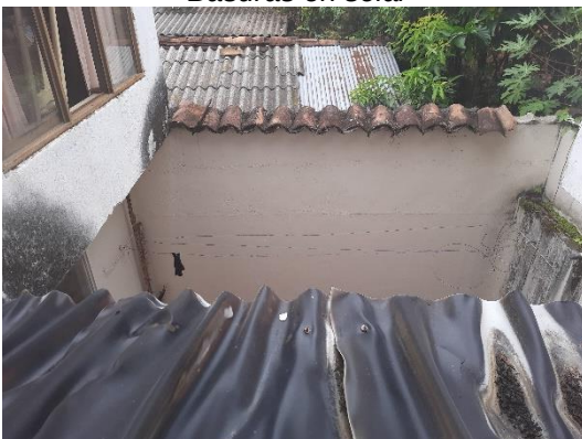
Vista de vacío al patio
