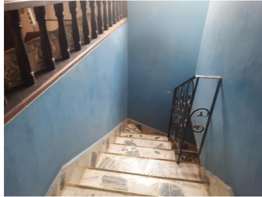
Detalle de escalera ingreso al piso 2
