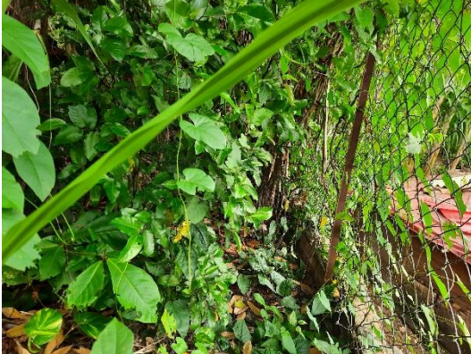
Estado del solar- lindero malla
