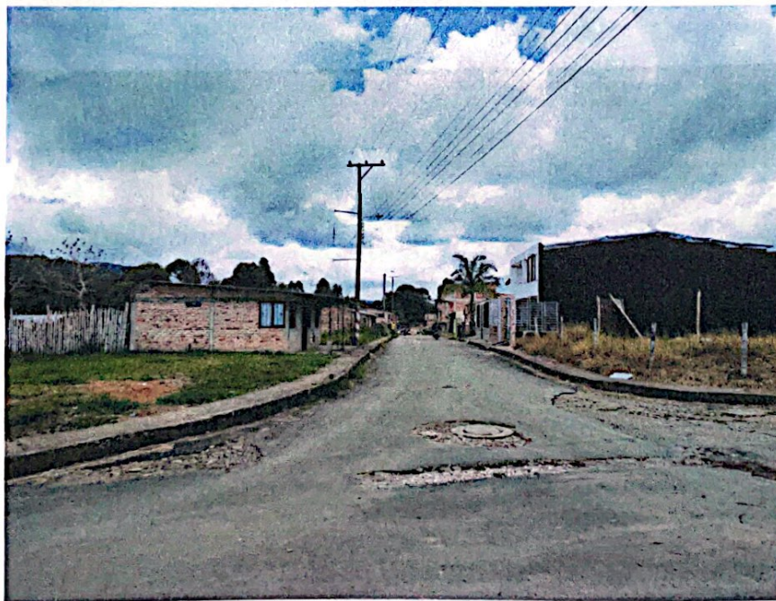
Calle 29, de la Urbanización Piendalinda
