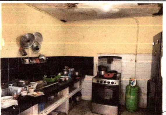
PANORAMICA INTERIOR COCINA
