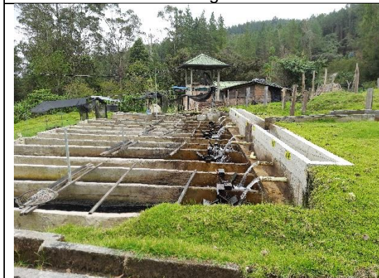
Vista general anques de levante
