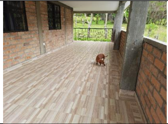
Detalle corredores en piso 2
