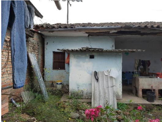
Vista fachada baño
