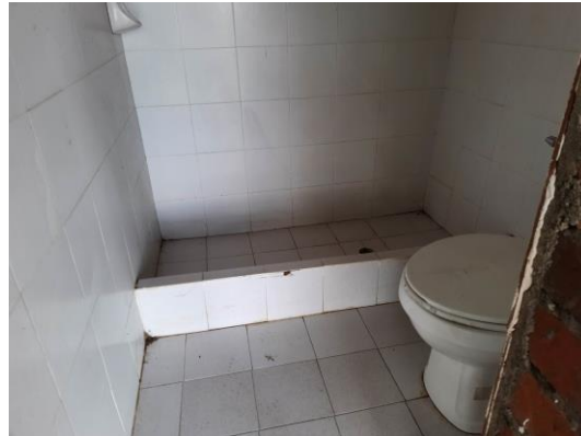
Detalle baño casa 2 piso 2
