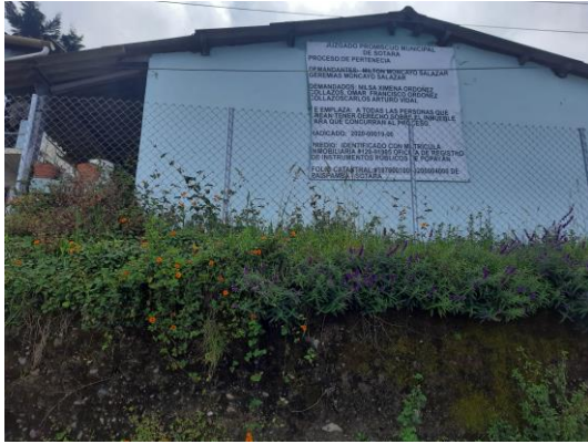
Detalle frente sobre la vía pública cra 1A
