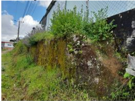
Detalle muro contención frente calle publica
