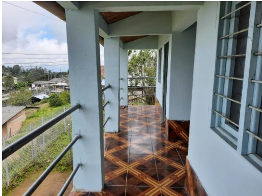
Corredor tipo balcón casa 2 piso 2
