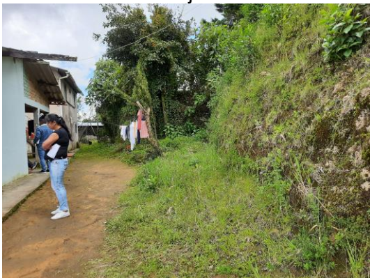
Lindero con el colegio sin cercas y barranco o talud
