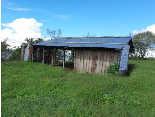
Detalle construcciones en el predio
