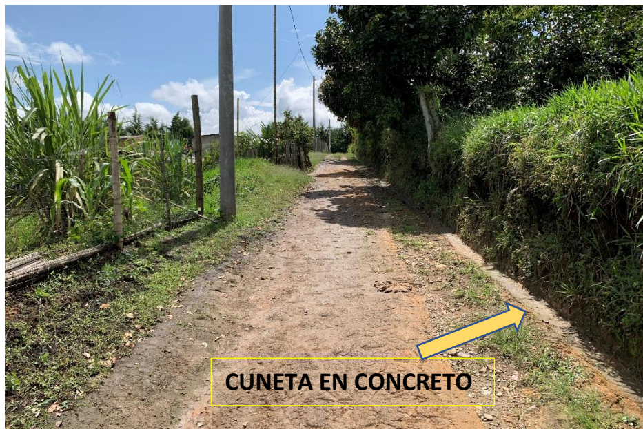
Fotografía No. 4. conformación de la vía de ingreso al predio, después del primer sector de la placa huella. Conformación de cuneta en concreto para drenaje del agua de escorrentía superficial.
