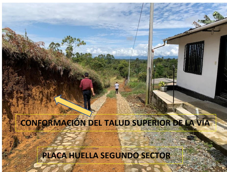
Fotografía No. 5. Conformación del talud superior la vía de ingreso al predio, y segundo tramo de placa huella.
