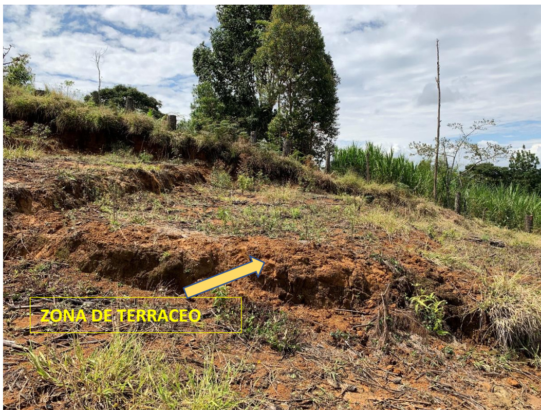
Fotografías No. 6 y 7 terraceo para posterior cimentación de las viviendas.
