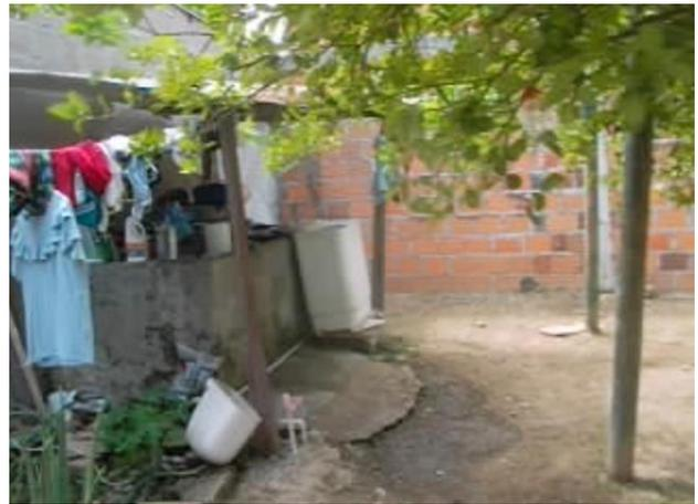
**LAVADERO EN CEMENTO, CON ALBERCA, TECHADO EN ZINC SOBRE ESTRUCTURA DE MADERA**
