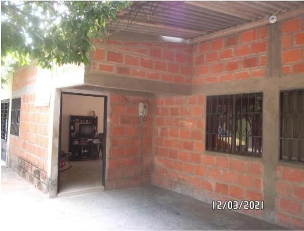
Otro ángulo de la terraza, con sus dos ventanas y la puerta de acceso. Cubierta ondulada tipi eternit, sobre estructuras de cerchas metálicas en el borde y de madera en general
