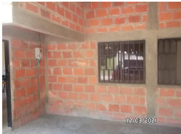
Terraza de acceso a la vivienda, puerta y ventanas en perfiles metálicos, corredizas, detalle del contador de energía eléctrica, columna de soporte compartida entre dos viviendas, columna de refuerzo y viga de amarre en concreto reforzado
