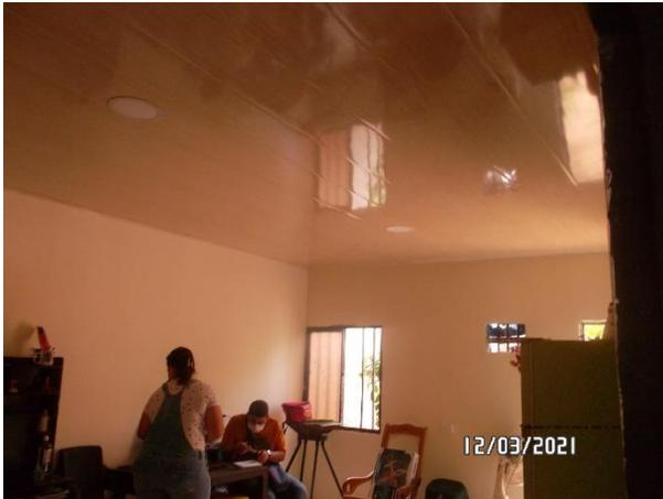
VISTA DE LA SALA DE RECIBO, COMEDOR Y COCINA, CIELO RASO EN LAMINA DE PVC, PAREDES PAÑETADAS, ENYESADAS Y PINTADAS, PUNTOS ELECTRICOS ENBEBIDOS A MUROS Y CIELO RASO
