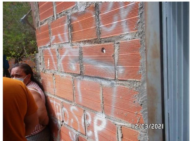
**PARTE POSTERIOR DEL BAÑO EN CONSTRUCCIÓN, HACIA EL PATIO, PUERTA METÁLICA DE SALIDA AL PATIO, PAREDES SIN PAÑETE**
