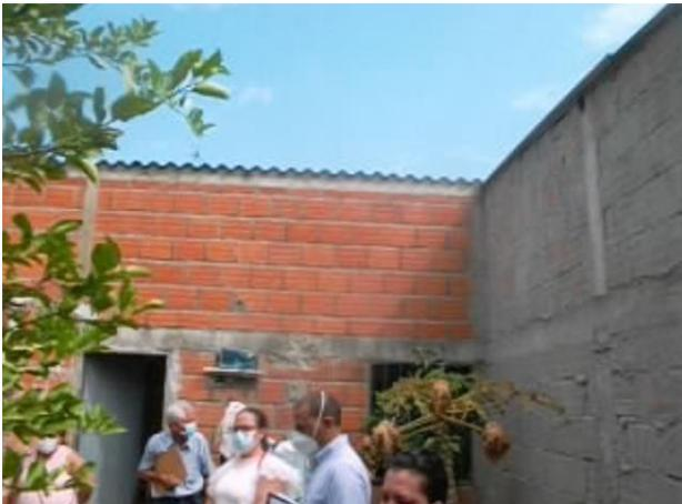
**PARED DEL FONDO DE LA CASA, EN LADRILLO DE GRES H7, CON COLUMNAS Y SU VIGA DE AMARRE, CUBIERTA EN TEJA ONDULADA TIPO ETERNIT. LA PARED EN BLOQUE DE CEMENTO A LA DERECHA EN LA FOTO, NO PERTENECE AL PREDIO**
