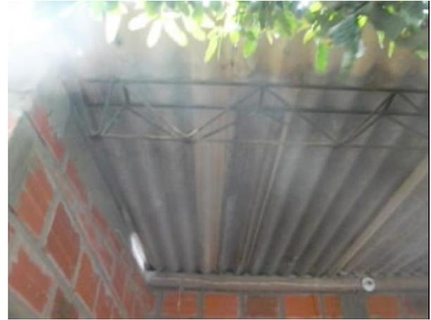
**VISTA DE LA CERCHA METALICA DE SOPORTE DE CUBIERTA EN LA TERRAZA DE ACCESO Y LISTÓN DE MADERA DE APOYO POSTERIOR**
