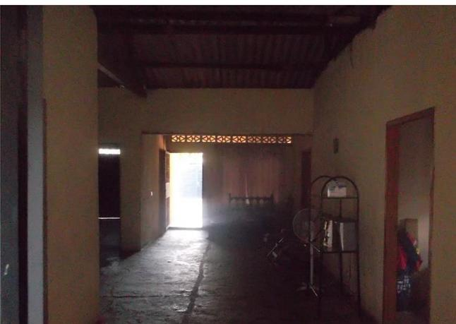
**VISTA DESDE LA PUERTA DEL PATIO, HACIA LA CALLE LA SALA DE RECIBO, PAREDES PAÑETADAS, ENYESADAS Y PINTADAS, PUNTOS ELECTRICOS ENBEBIDOS A MUROS, SIN CIELO RASO**
