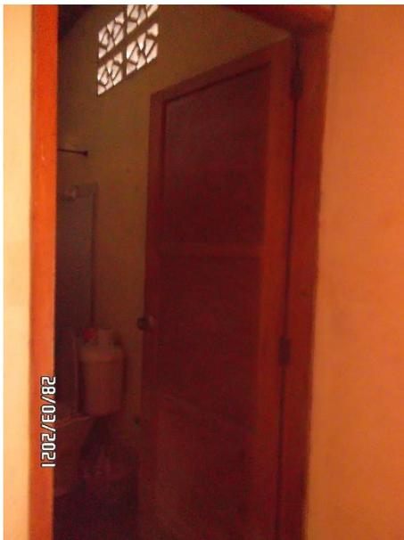
**PUERTA DE MADERA DEL BAÑO AUXILIAR, PAREDES SIN ENCHAPE, EN LA DUCHA, ENCHAPE A MEDIA ALTURA**
