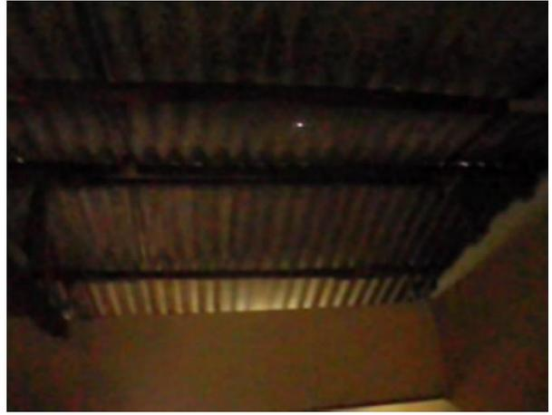
**FOTO MOSTRANDO LA ESTRUCTURA DE CUBIERTA EN LISTONES DE MADERA Y LAS LÁMINAS ONDULADAS, TIPO ETERNIT**
