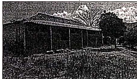
Cubierta en láminas de asbesto cemento y columnas en concreto.
