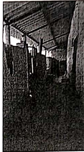
Vista Interna del corredor.
