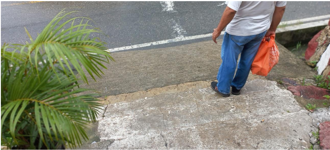
Placa sobre canal
