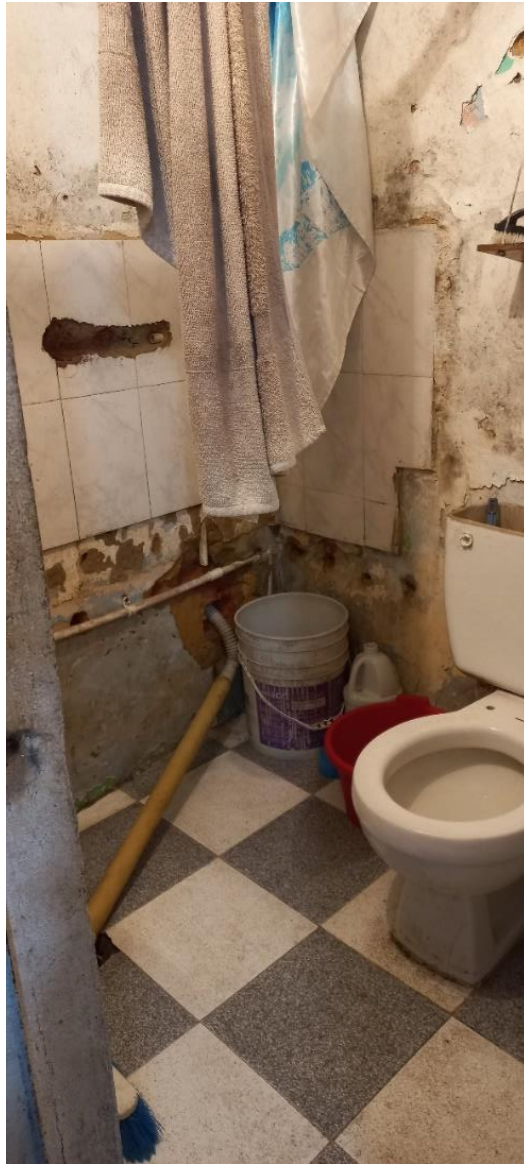
Baño pisos enchapados, muro enchapado y pintado, sanitario
