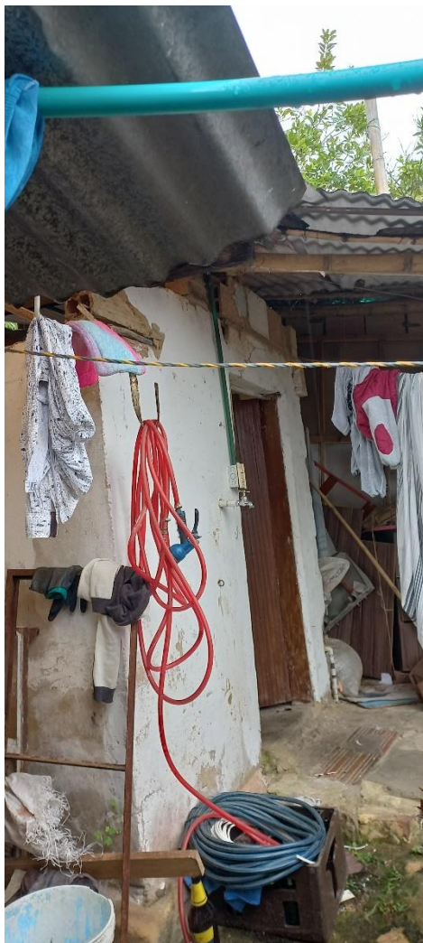
Patio de ropas, entrada al baño, puerta en madera, red eléctrica
