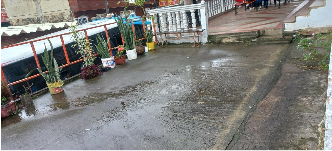
Placa en concreto, baranda en tubo metálico, bordillo en ladrillo pañetado
