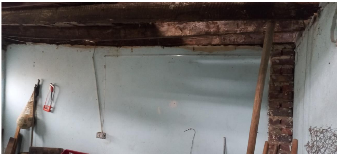
Muro alinderante de 8 metros, observando solo una fracción ya que está dividido en dos partes
