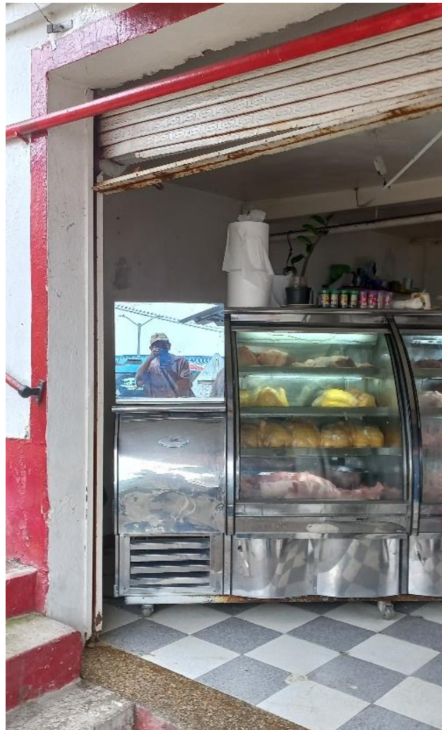
Local Fama, pisos enchapados, puerta metálica, paredes pintadas
