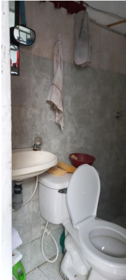
Baño con sanitario, lavábamos, enchapado
