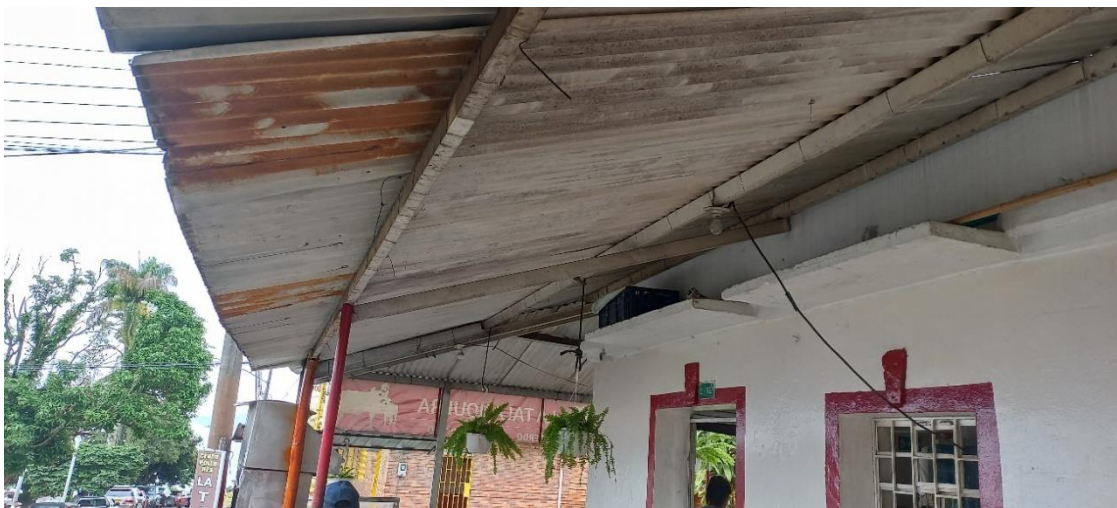
Alero en teja zinc y cerchas metálicas, paredes pintadas, ventanas metálicas
