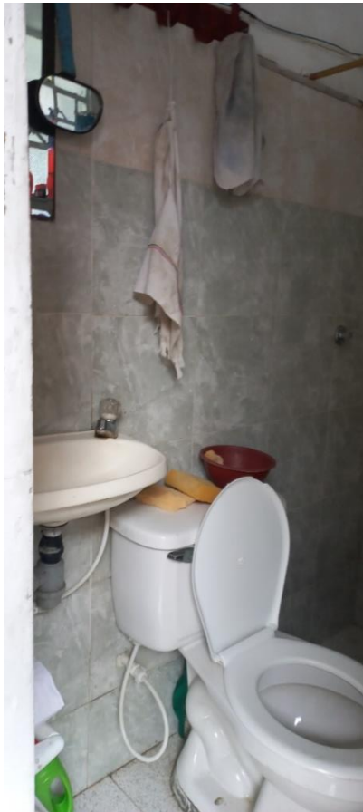
Baño con sanitario, lavábamos, enchapado
