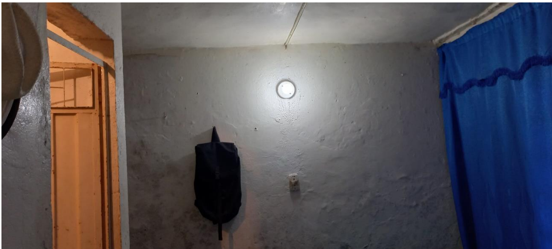
Puerta metálica del baño, luminaria, pared pintada
