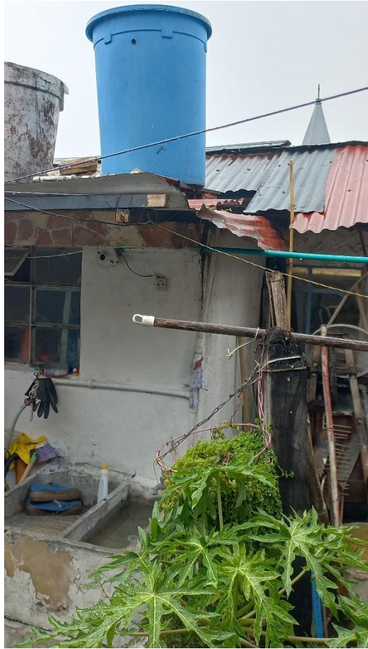
Lavadero, tanques de reserva, ventana metálica
