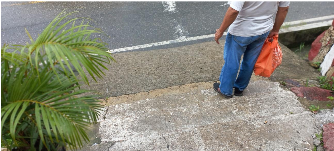
Placa sobre canal
