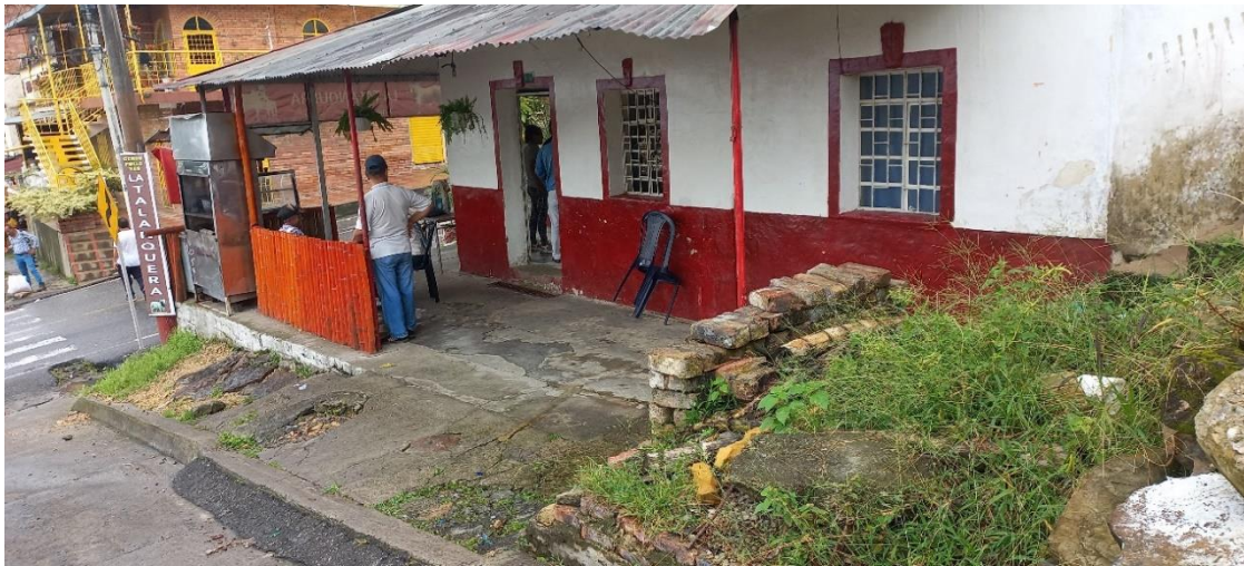
Local comercial ventanas metálicas, alero en teja zinc
