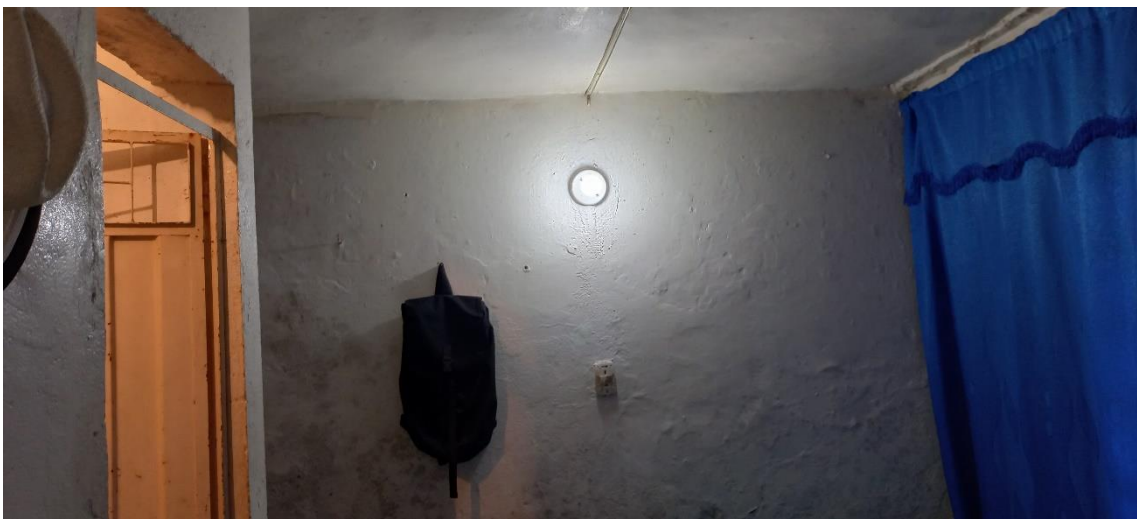
Puerta metálica del baño, luminaria, pared pintada
