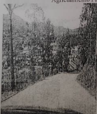
Vista predio / inestabilidad vía
