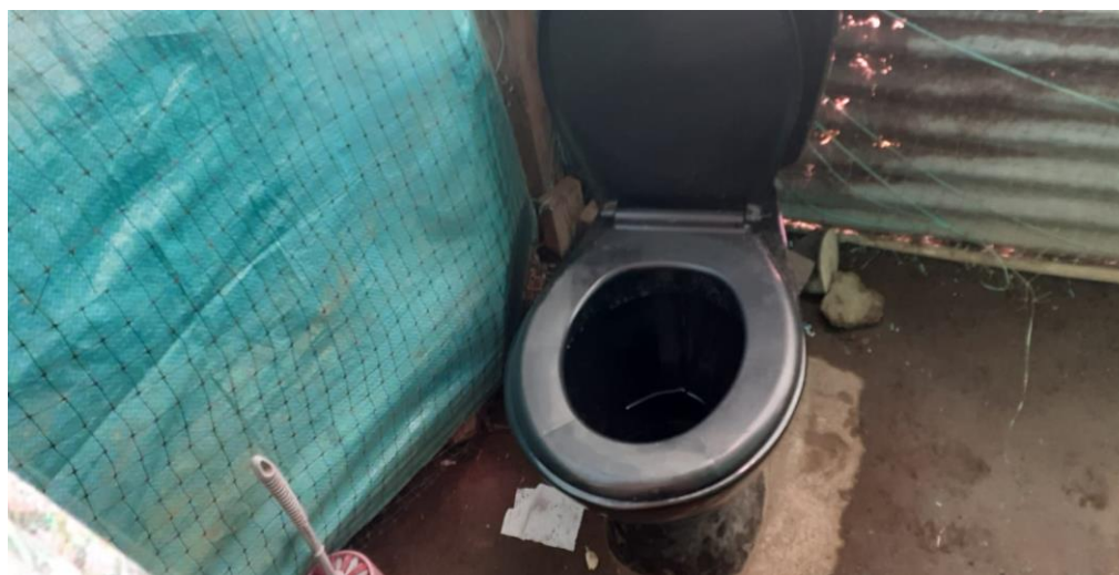
VISTA DE LA COCINA Y BATERÍA SANITARIA
