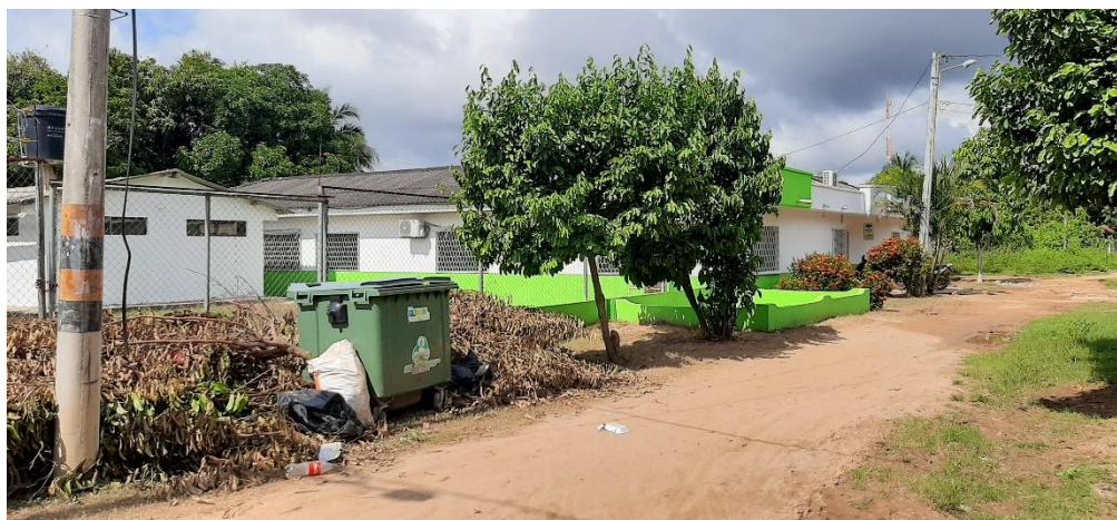
Fachada lateral calle 12
