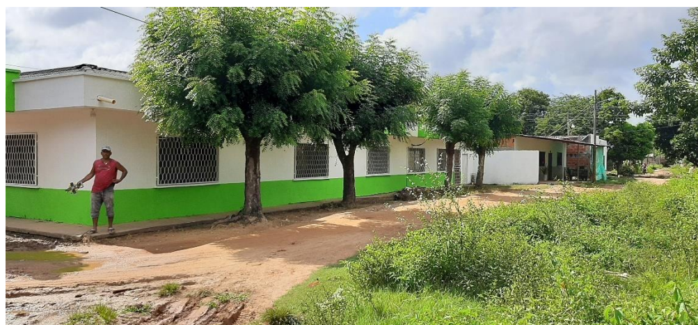
Fachada lateral carrera 9
