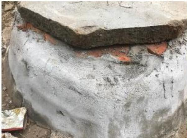
Ilustración 1 Manhol construido para las aguas residuales de la cra.6.
