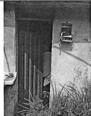
VISTA CARPINTERIA METÁLICA
