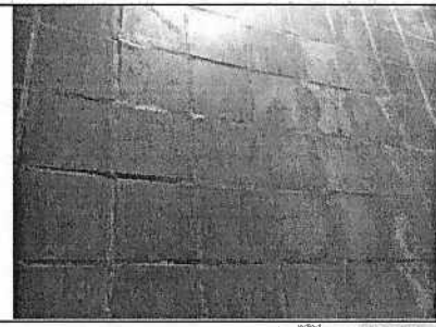
VISTA REVESTIMIENTOS DE PISOS
