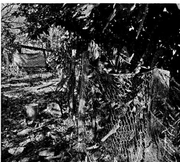
ENCERRAMIENTO EN LAMINAS METÁLICAS, POSRES DE MADERA Y MALLA
