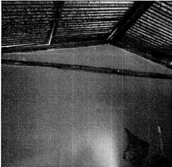
PISO EN CEMENTO Y CUBIERTA EN ZINC ALCABA
