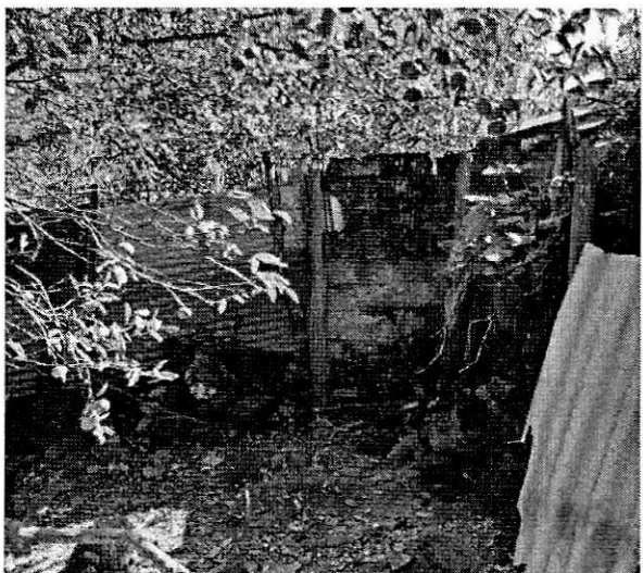
ENCERRAMIENTO EN LAMINAS METÁLICAS, POSRES DE MADERA Y MALLA
