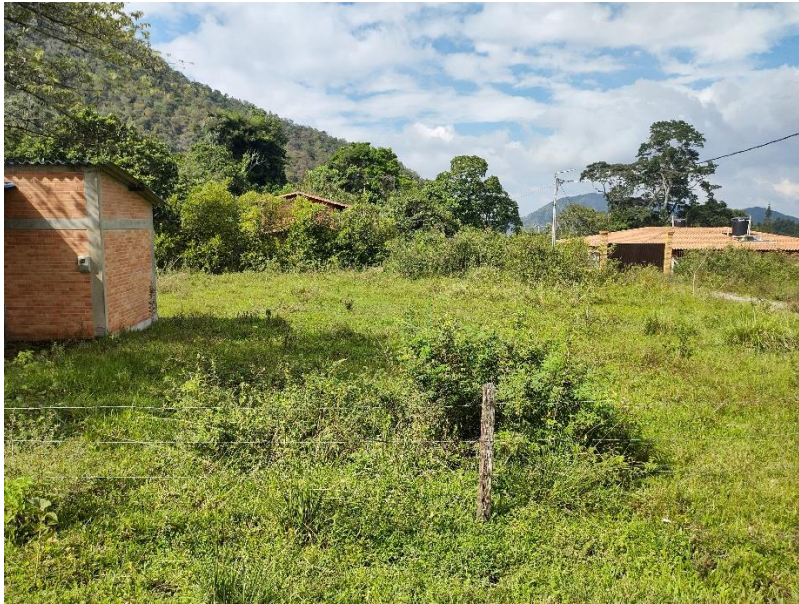
Vista desde el costado sur hacia el norte
